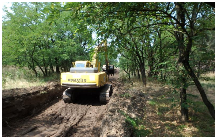
11. ábra. Tereprendezés a Pa-21-II jelű árok nyomvonalán mentén
