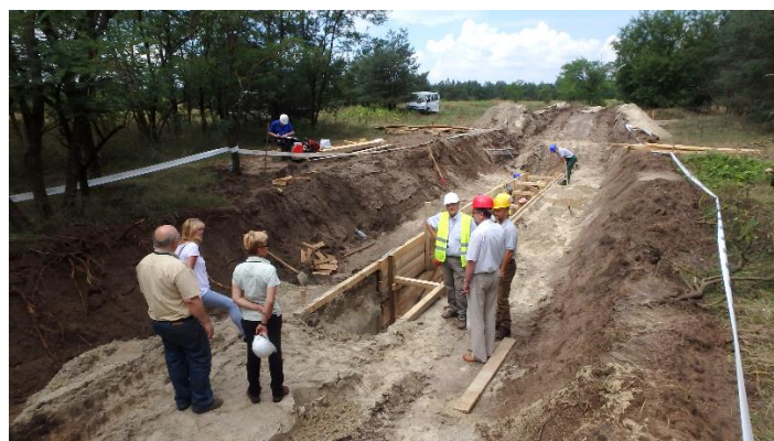
12. ábra. A szakaszos árokhajtás negyedik üteme, mélységben a harmadik fogás (talp -2 m) kihajtása zajlik, a felső két 66 cm-es mélységszakasz támfallal biztosított
